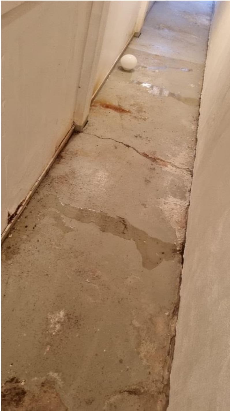
Vannmengder som lekker ned fra bassengrom
