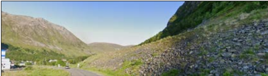
Figur 22 Bilde av eksisterende skredvoll. Kilde: Google maps
