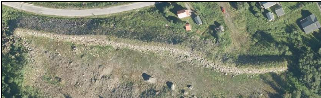
Figur 23 Bilde av eksisterende skredvoll. Kilde: Norgeskart
