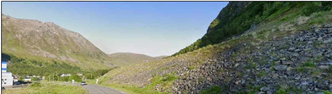
Figur 22 Bilde av eksisterende skredvoll. Kilde: Google maps
