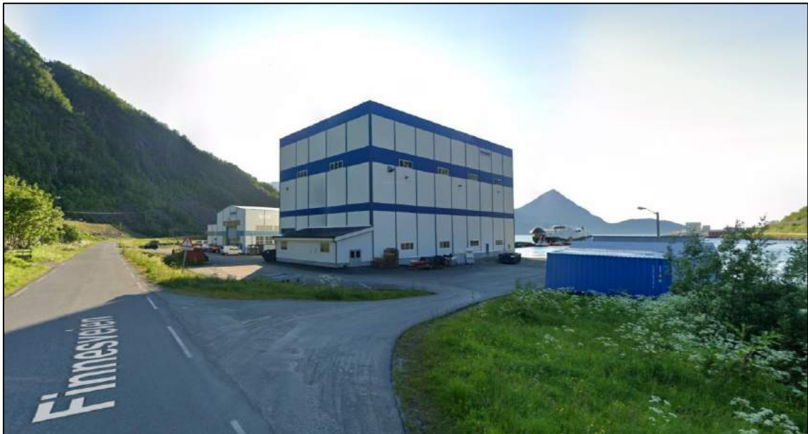
Figur 4 Bilde tatt mot nord-øst. Kilde: Google maps, 2019
