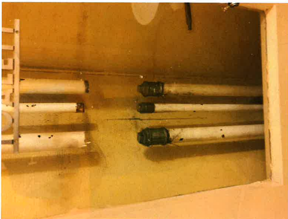
Figur 17 Åpne blokkerte rør bak dør ved toaletter
