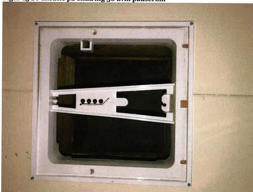
Figur 14 Passive ventiler går kun til ytre veggplater
