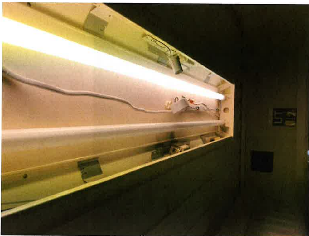
Figur 9 Deksler mangler og lys er gått
