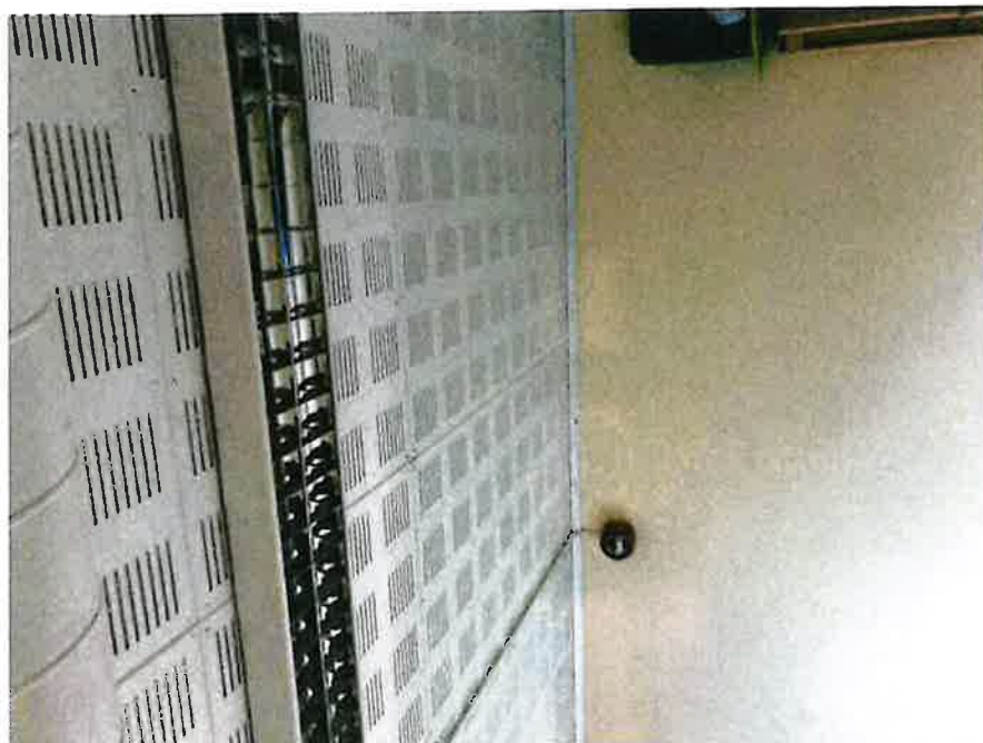
Figur 3 Harde himlingsplater som bør monteres senket, flyttes fra 2. etg. og ned.
