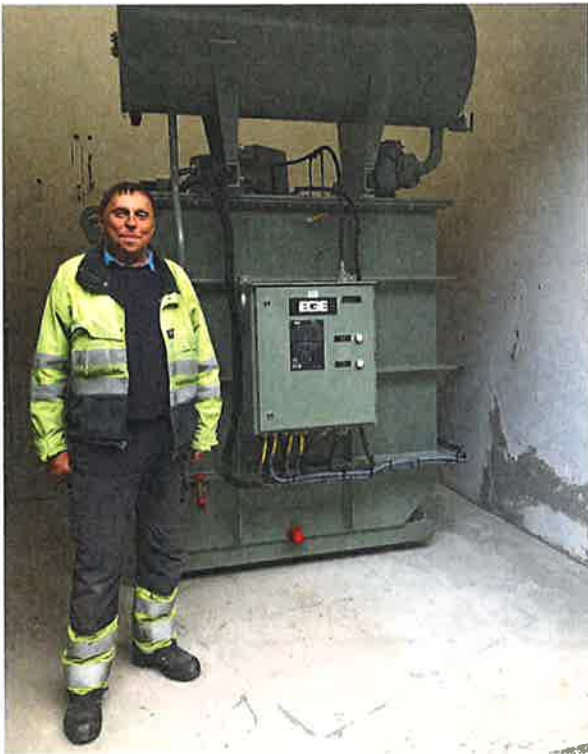
Maskinist Sevald Fredriksen ved jordspolen i Hamneidet transformatorstasjon. Foto: Elin Kaasen.
