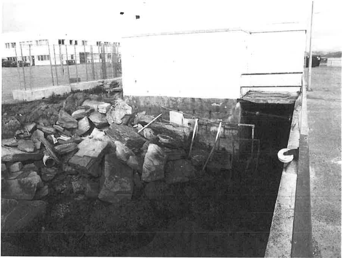
Plastring i sjøkant.
