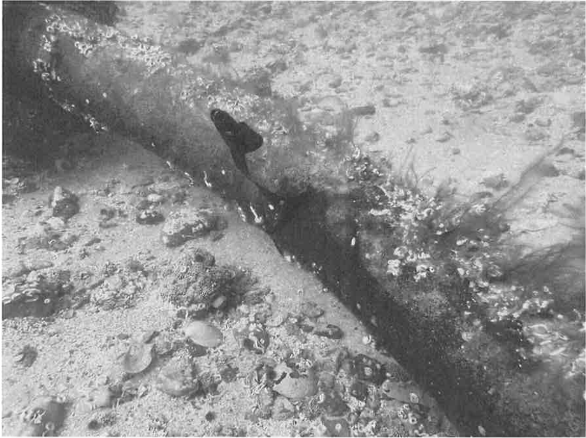
Skade mest sannsynlig etter anker fra båt. Rør gjør her en skarp sving også.
