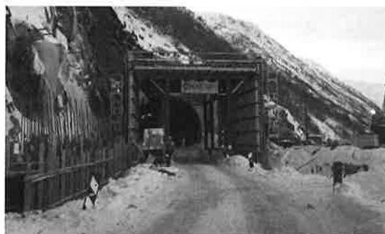
Rassikringsarbeid ved Øksfjordtunnelen. Foto: SVV
