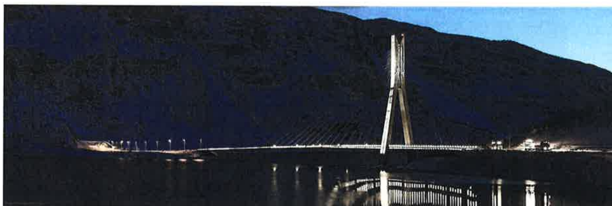
Kåfjordbrua E6, foto: SVV
