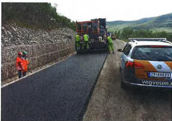
Oppgradering av fv.98, foto: FFK
