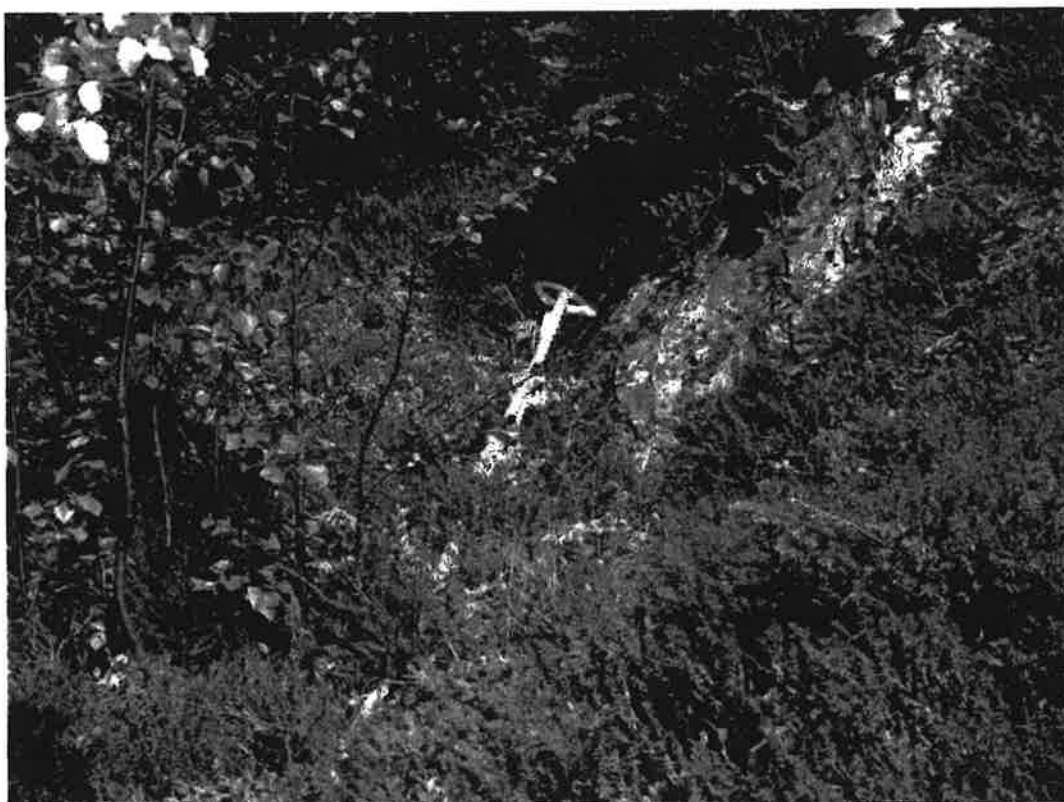
Figur 7. Wire med wireklemmer og øyeboltforankring.
