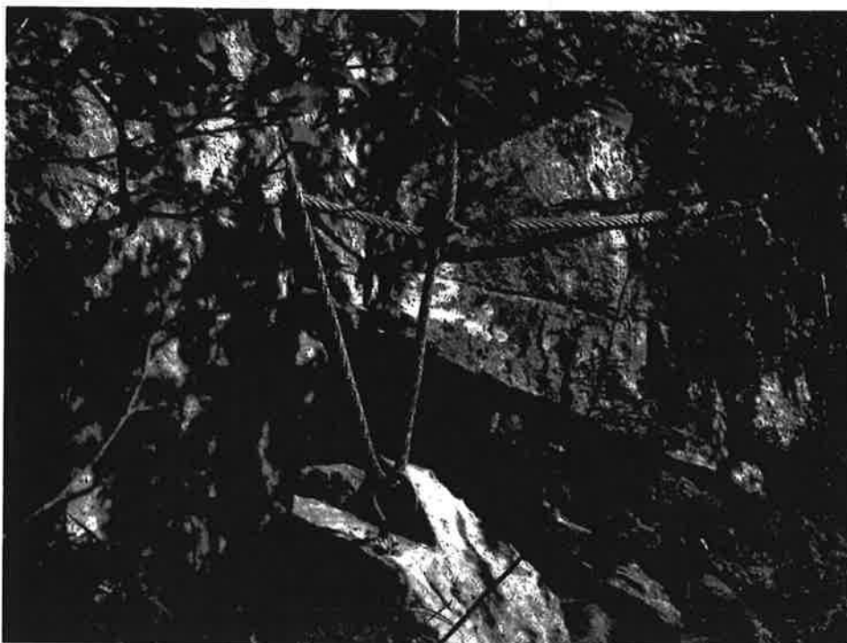
Figur 6. Sikring av avløst blokkparti ved Plataået nr 7.
