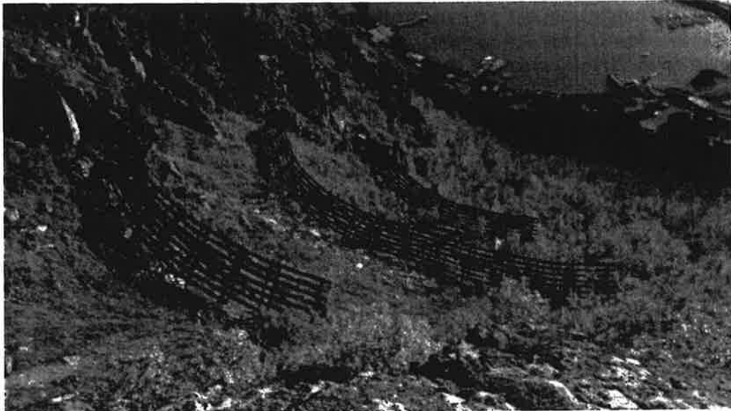
Figur 16. Oversiktsbilde av støtteforbygninger
