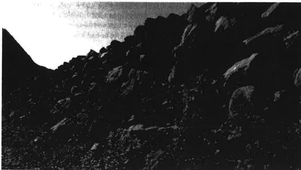
Figur 15. Oppsiden av sikringsvollen
