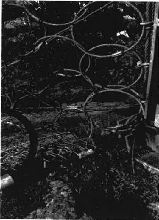
Figur 3. Korrosjon på bunnwire
