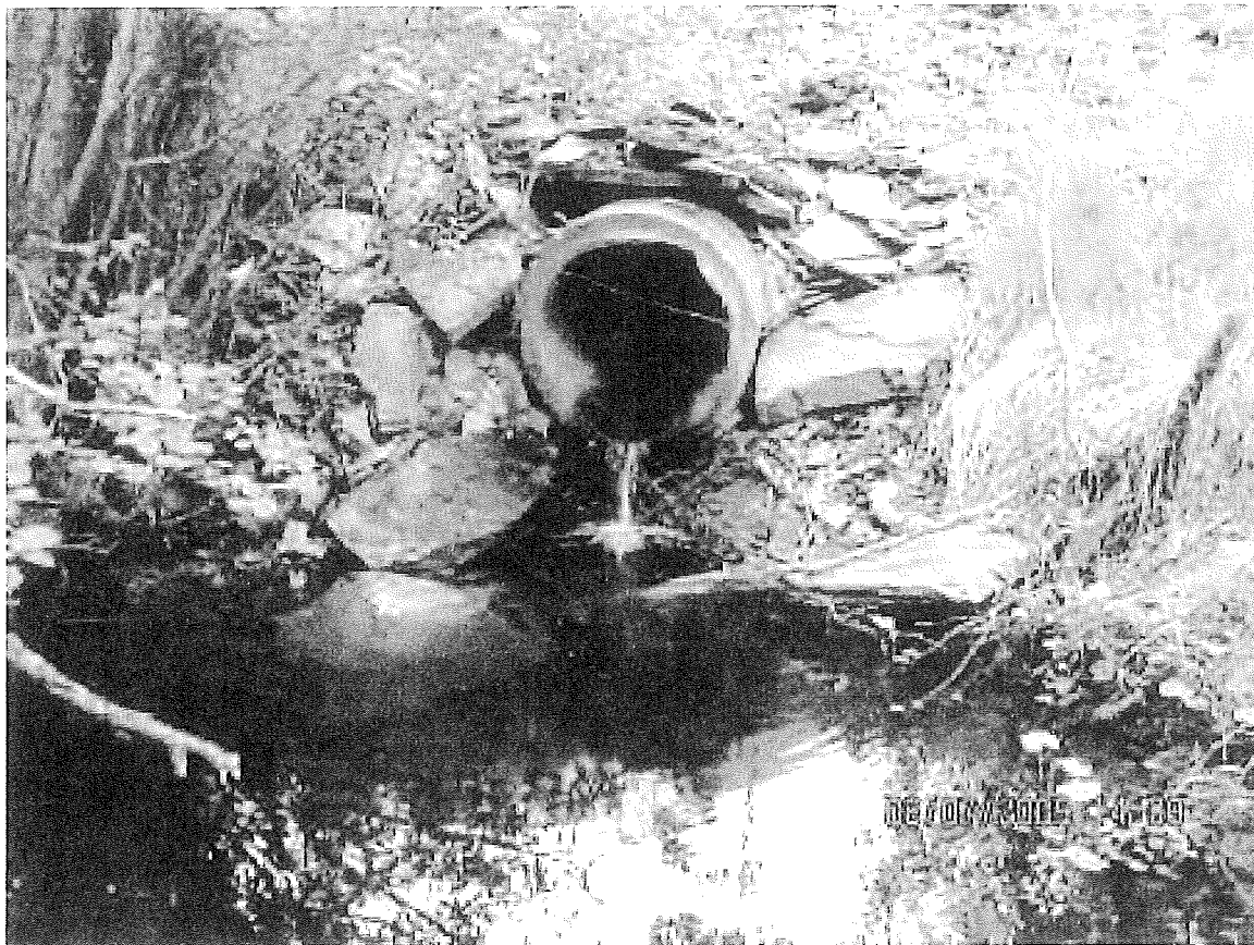
Figur 2.5 Bildet viser vandringshinderet Engdal fra vannforekomsten "Bekk fra Raigorivannet"/212-526-R i Tverrelvdalen i Alta. Ved utløpet av betongrøret er det 30 cm sprang ned til vannspeilet. Foto: Statens vegvesen
