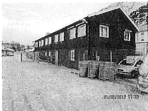
Småbedriftssenteret sett fra syd på kai.
