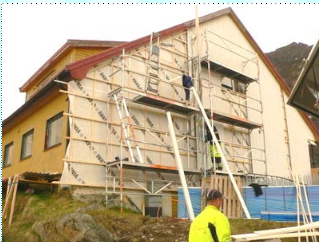
Øksfjord samfunnshus under utbygging/renovering
